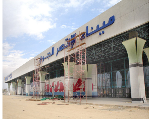
صورة ١٣ مطار الأقصر الدولي واستخدام زهرة اللوتس المجردة في الأعمدة والواجهات التي يتم تشكيلها من هياكل معدنية وتكسياتها من القاشاني الملون
