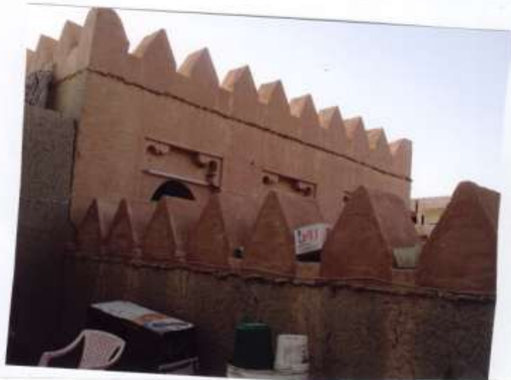
لوحة (38) الواجهة الشرقية لمسجد الخميساني و القناء الذي يتقدمها من جهة الشرق، (لاحظ الشرفات)
