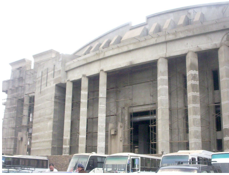
صورة ١٦ استخدام التقنيات والخامات الحديثة بما يعكس الصورة المصرية المقترضة في مبنى يتعامل معه المصريين والأجانب من جميع أنحاء العالم.
