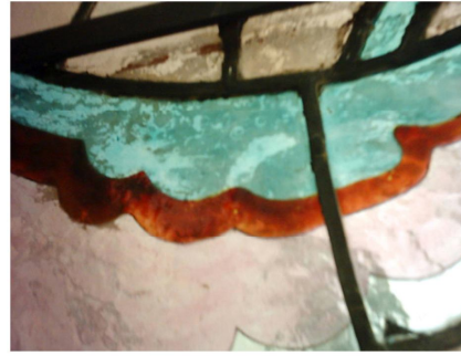
عدم اتجاه خط القطع في الترميم السابق على ملونات غير مناسبة
