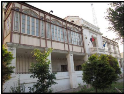
لوحة رقم (١٢) القنصلية الفرنسية بحي الشرق بمدينة بورسعيد ١٣١٨ هـ / ١٩٠٠ م (تصوير الباحث)
