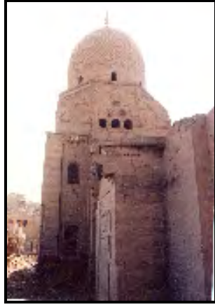
لوحة ٣ - الواجهة الجنوبية الشرقية لرباط أزدر بجوار قبة طراباي قبل الترميم
