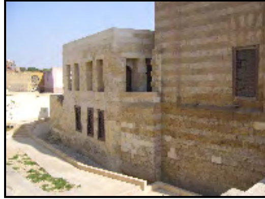
لوحة ١١ - الواجهة الشمالية الشرقية للرابط بعد الترميم وإزالة الرديم أمامها
