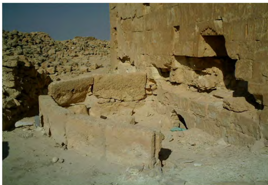
صورة رقم (7) الواجهة الجنوبية الشرقية لجامع قلعة صدر(الجندی) و أسفلها فتحة الصهریح تصوير الباحث
