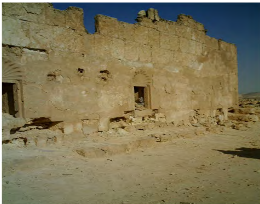
صورة رقم (6) الواجهة الشمالية الشرقية لجامع قلعة صدر(الجندی) تصوير الباحث
