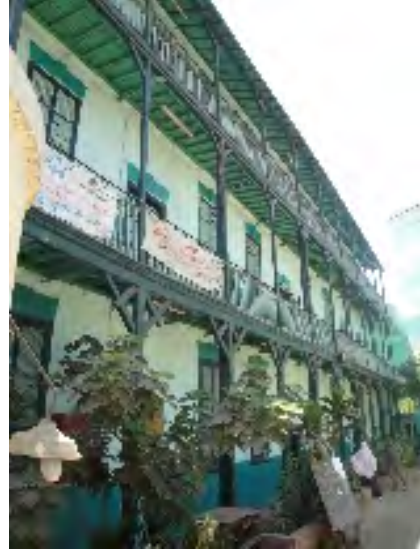
(١)الواجهة الغربية من المبنى الأول
