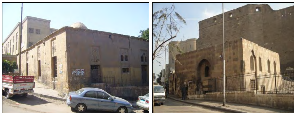
(لوحة ١) شارع سكة المحجر أسفل السور الشمالي للقلعة وزاوية حسن الرومي (لوحة ٢) التكية : الواجهتان الجنوبية الشرقية والشمالية الشرقية
