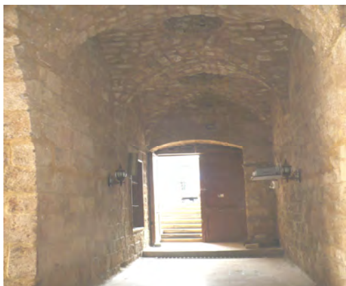
لوحة رقم ١٩ القبو المروحي بممر جامع التوبة
