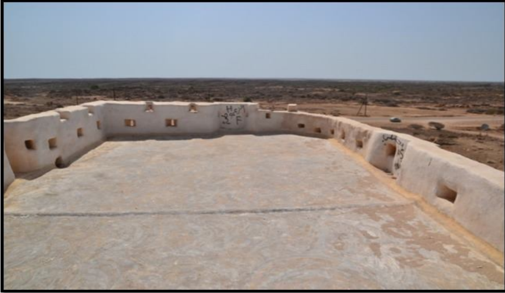
لوحة رقم (١٢) القلعة العثمانية- سطح المنشأة،الواجهة الجنوبية بأقصى اليمين،الواجهة الشرقية بالمنتصف، الواجهة الشمالية بأقصى اليسار، وتتضح السقاطات وفتحات المزاعل.
