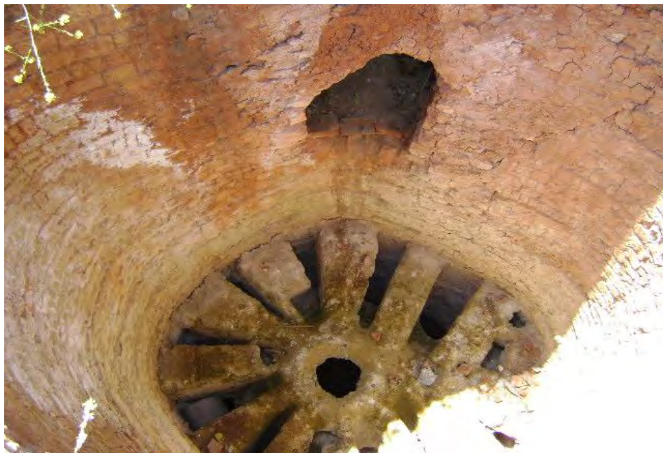
منظر لغرفة الحرق
