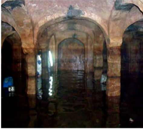
اللوحة (٥) فتحة المدخل إلى غرفة الصهريج اللوحة (٦) غرفة الصهريج والدعامات التي ترفع قبابه الضحلة
