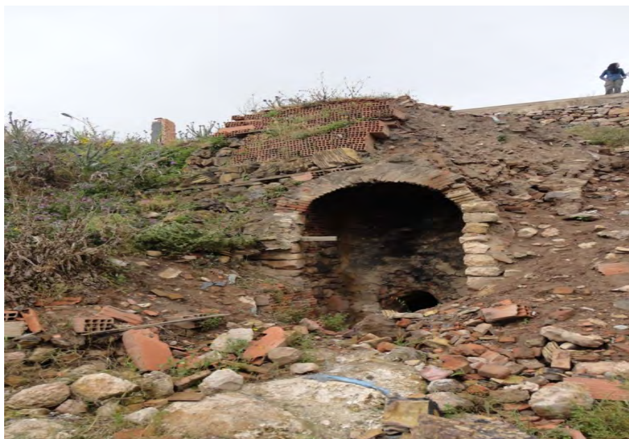
الفرن قبل التنظيف والترميم
