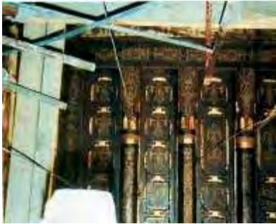
السقف أثناء الترميم
