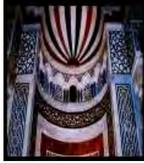
أ- الكتل الرخامية المحفورة بعد الترميم ب- الجزء العلوى للمحراب بعد الترميم والتقوية ج- الرخام المعشق بعد الترميم (فسيفساء)
