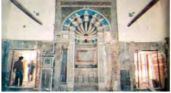
أ- تهالك تام فقد العمود الأيسر إزالة أجزاء كثيرة من الرخام الإتساح التام فصل المحراب عن الحائط بحوالى ٣٠ سم خروج
