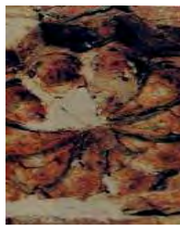
طمس لدرجات اللون الزيتية التي استخدمت في الترميم الخاطي على السقف
