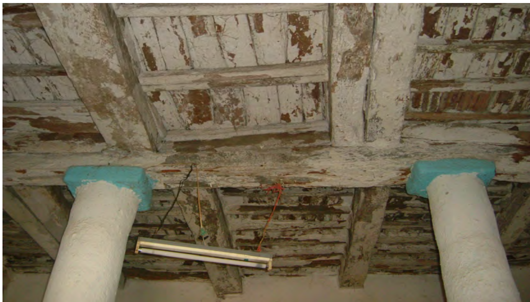
(لوحة ٧) تظهر نوع الدعايم التي تحمل السقف
