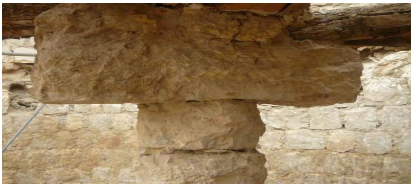
لوحة رقم (١٣) قطعة حجرية مستعرضة اعلي العمود لحمل الروابط الخشبية والعقود.
