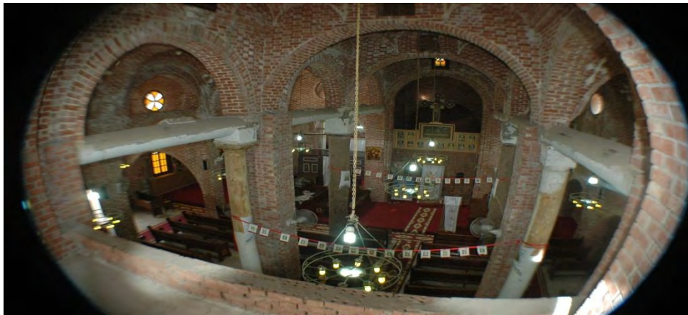
Fig 12- Les quatre anciennes colonnes soulèvent la nef centrale de l'église
