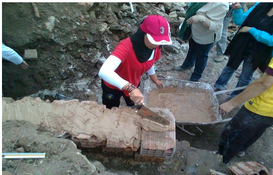
الفرن أثناء عملية الترميم (استعمال المواد المحلية)
