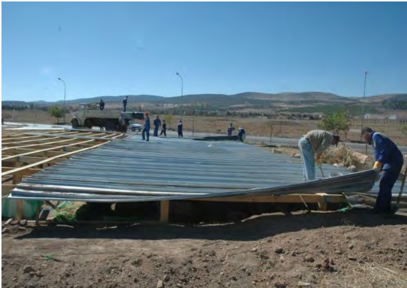
الصورة ١٢ : تشييد الملجأ لحماية موقع الحفرية عن الباحث
