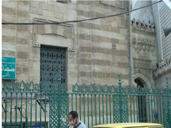
لوحة (٣) جزء من الواجهة الرئيسية والمدخل الثانوي
