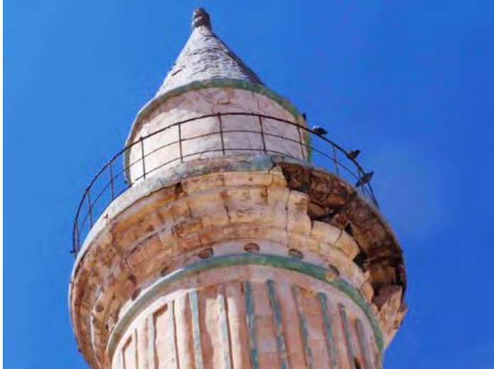
لوحة (٤) صورة تبين التصدعات التي أصابت منڈنة جامع رشيد باشا
