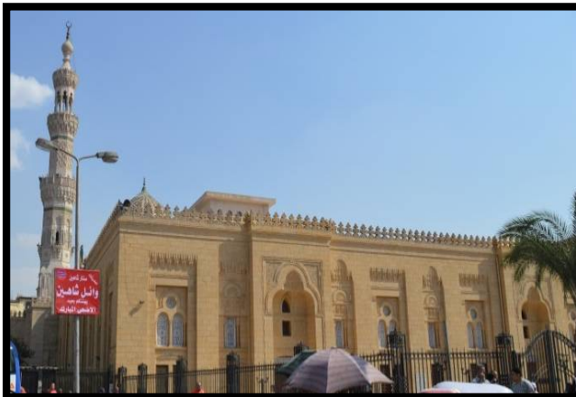
صورة رقم ٣ الواجهة الغربية بشارع السد - الباحة
