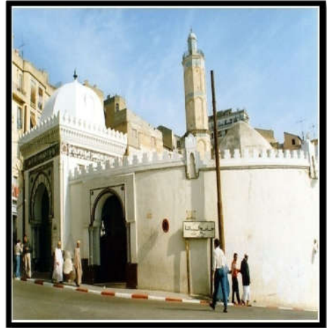
الصورة ٠٥: الواجهة الخارجية لجامع الباشا بوهران
