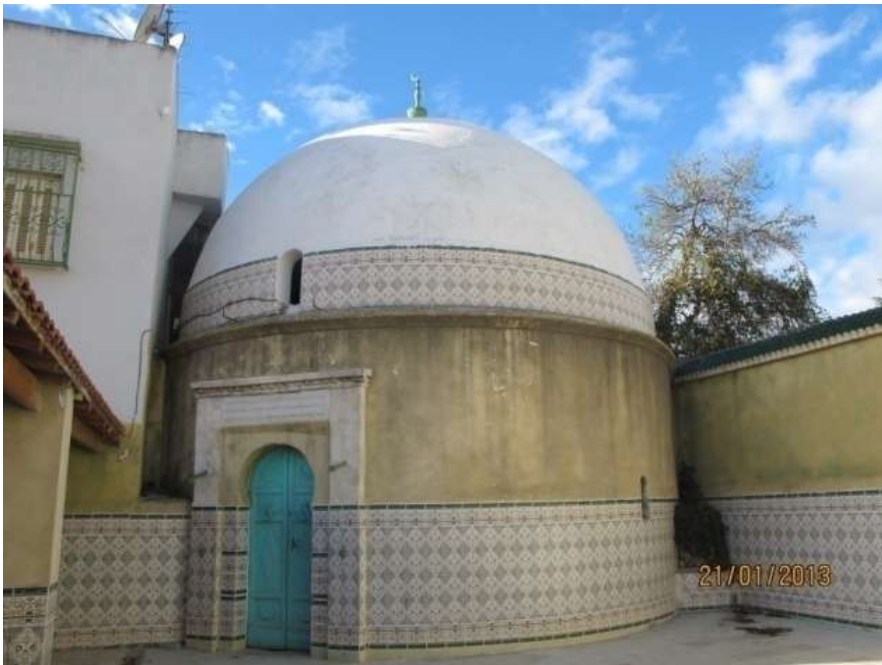
الصورة ٤: منظر خارجي لضريح سيدي السعد
