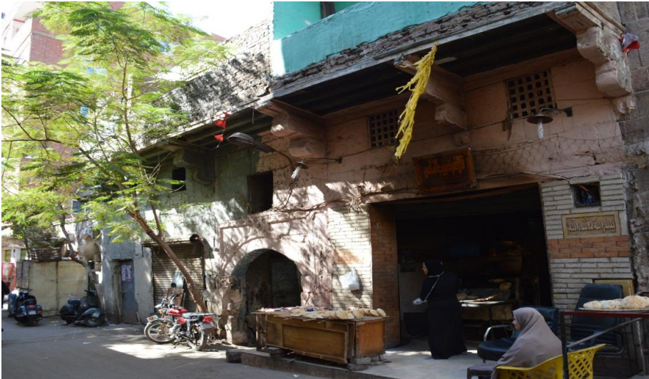
لوحة (٣) تبين الواجهة الرئيسية لوكالة حسن أفندي كاتب عزبان. "تصوير الباحثة"
