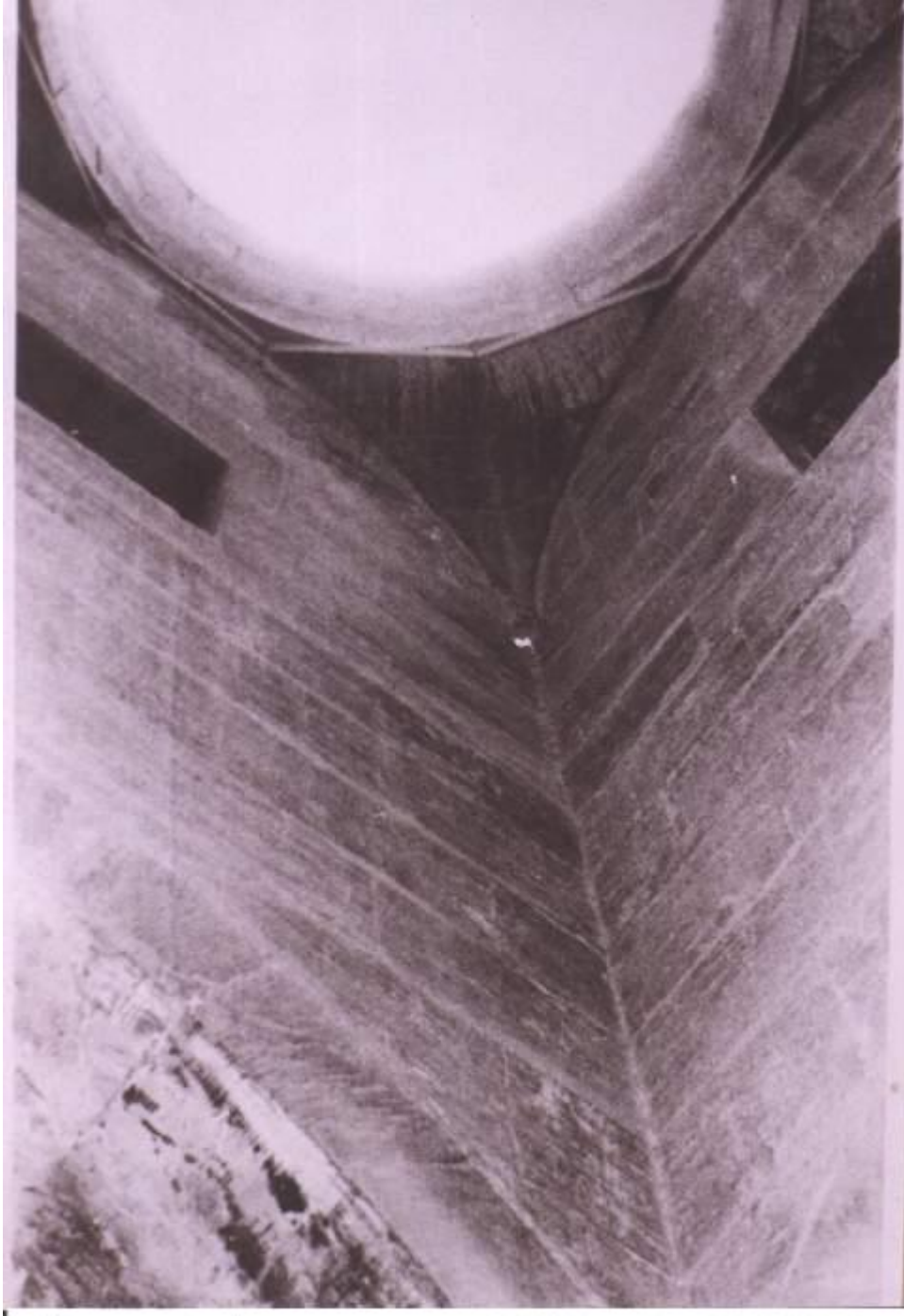
لوحة (٥) خانقاه سلار وسنجر الجاولى (١٣٠٣/٥٧٠٣-١٣٠٤م) بشارع مارسينا - القاهرة، قبو مروحي يعلو بسطة السلم المؤدى لداخل الخانقاه، وهو ذو قطب مفتوح اثني عشرى الأضلاع، بتأثير من الأقطاب الشامية المتسعة، ويعد هذا القبو أقدم مثل باق بعمائر مصر تصوير المؤلف
