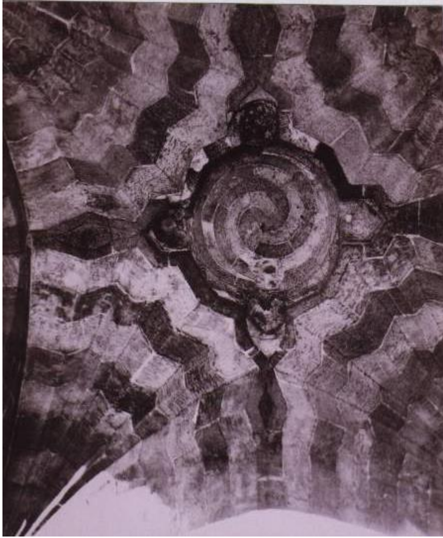
لوحة (٨) خان الخليلي (٩١٧هـ/١٥١١م) بالقاهرة، قبو مروحي يغطي دركاة المدخل الجنوبي للخان، وهو ذو أرجل رشيقية ممتدة يتوسطها قطب مركب، مما ساعد على زيادة أرجله إلى خمس في كل ركن منه، وهذا قمة النضوج المعماري الذي لم يحدث قبله ولا بعده تصوير المؤلف
