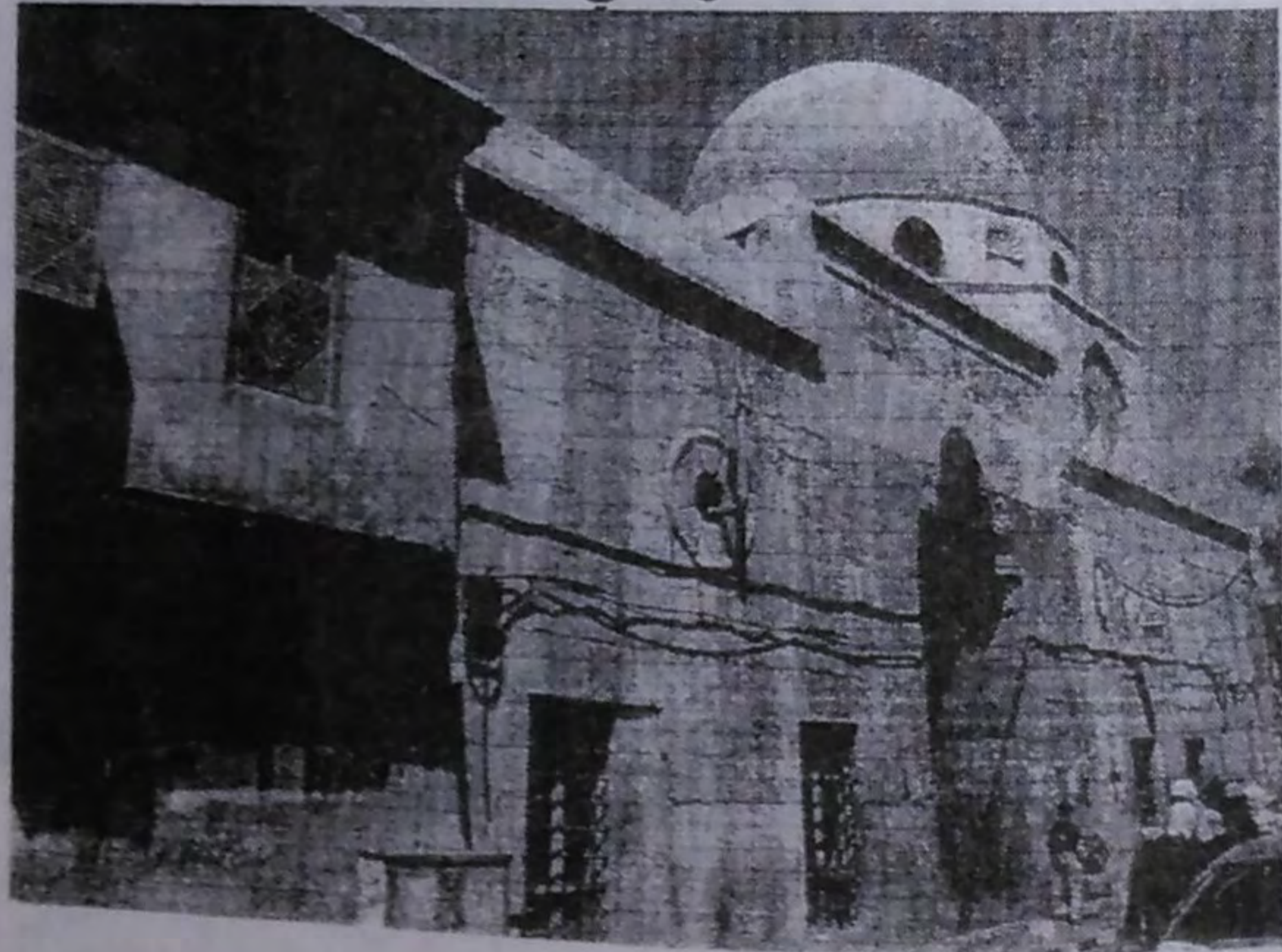
(لوحة ١٣) التربة التكريتية: الواجهة الجنوبية الرئيسية
