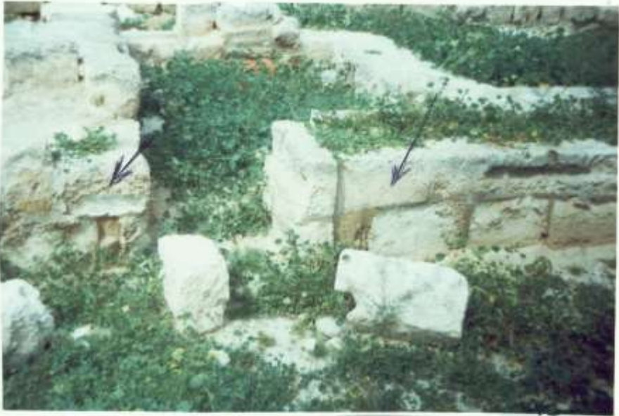
صوره ( ٧ ) توضح تأثير عوامل التلف على أحجار قصر اجدابه وظهور عامل النحر - وعامل التحويه الكيميائيه والميكانيكية وارتفاع نسبة الحشائش وتحويل لكريونات الكالسيوم الى كبريتات المانية .
