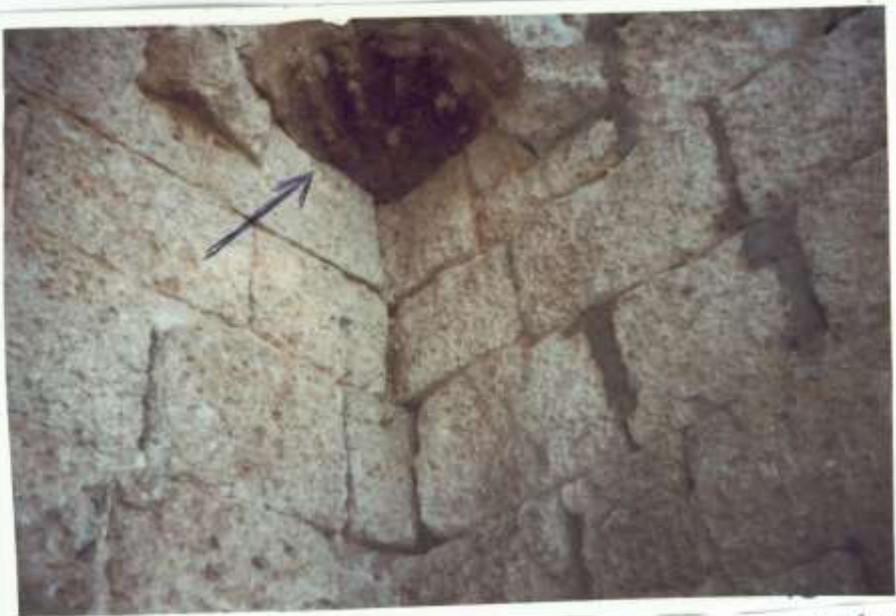
صورة (٦) توضح حنيه ركنية بمنطقة انتقال نصف قبة قاعة العرش وتأخذ شكل الخيارة .
