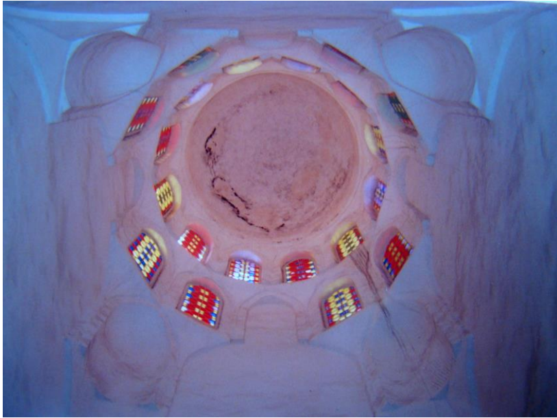
(لوحة ١٦) جامع التوريزي: منطقة الانتقال ورقبتي وخوذة القبة بالتربة
