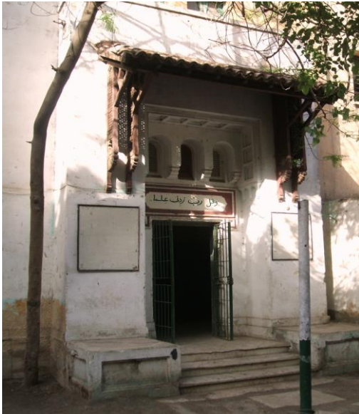
لوحة (٣٤) كتله المدخل الرئيسي للمدرسه
