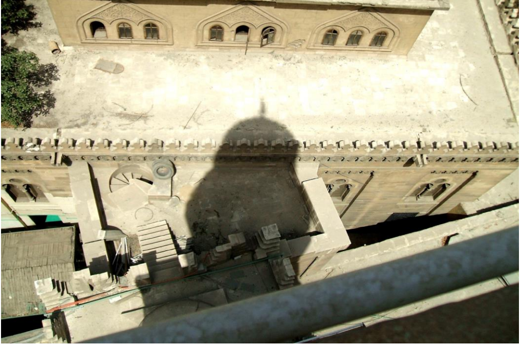
لوحة (١١) منظر يوضح الواجهه الجنوبيه الغربيه للمسجد وإزوارار كتلته عن الواجهه الجنوبيه(الرئيسيه) للمجمع
