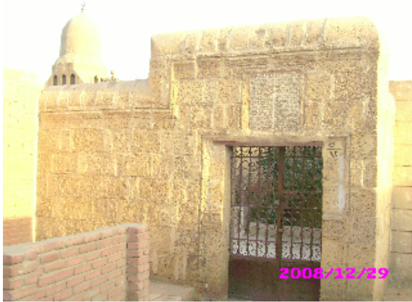
لوحة ١٤ : الواجهة الرئيسية بمدفن وسبيل مصاصة المنطلي ١١٩٥هـ / ١٧٨٠م
