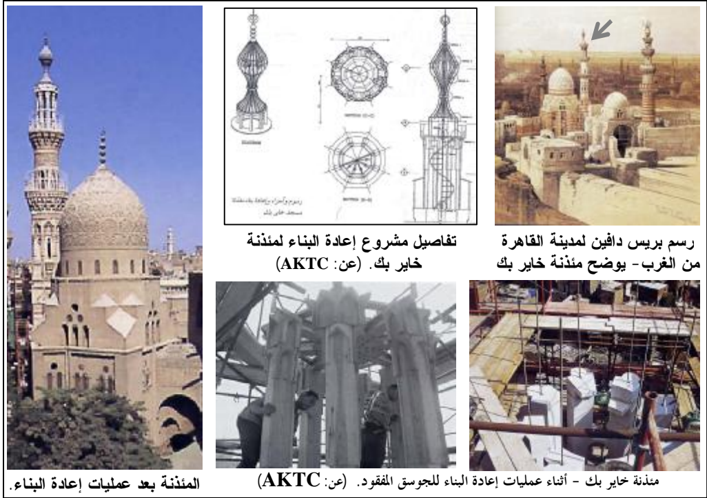
شكل (١٨): عمليات إعادة البناء للأجزاء المفقودة من مئذنة مجموعة خاير بك.
