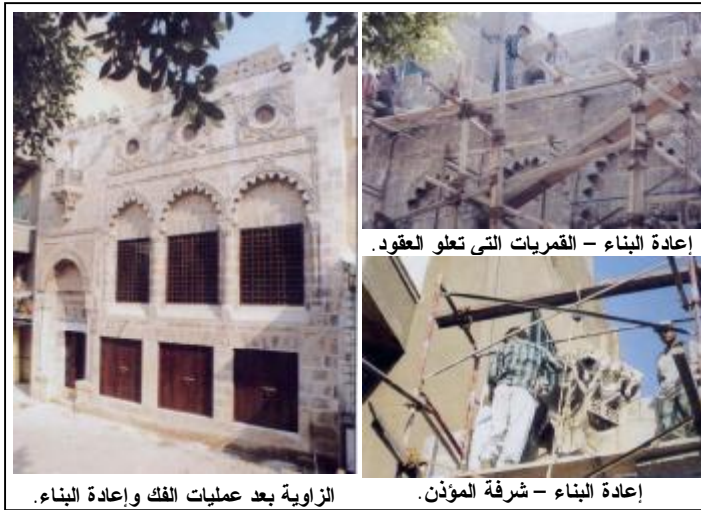
الزواية بعد عمليات الفك وإعادة البناء.
