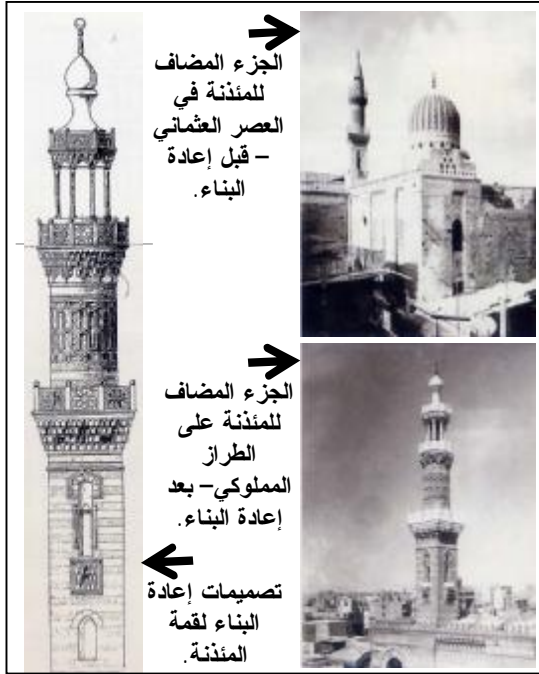
شكل (١٩): عمليات إعادة البناء لمئذنة مدرسة برسباي. (أرشيف لجنة حفظ الآثار العربية)
