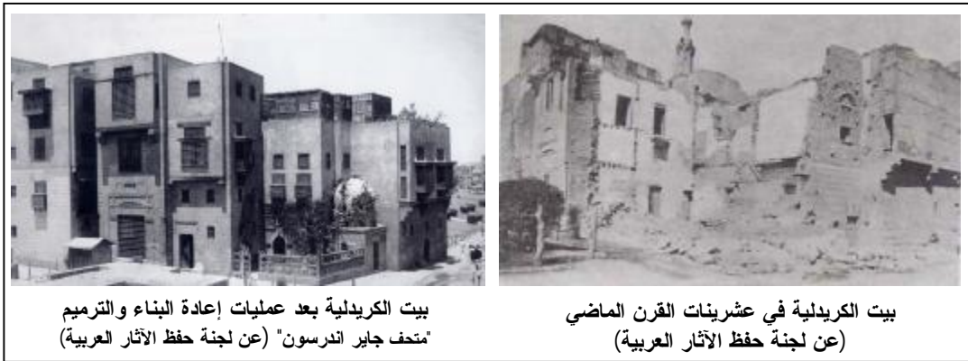
شكل (٥): عمليات إعادة البناء لبيت الكريدلية
