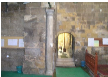
لوحة رقم (٦): المدخل المؤدى إلى دورة المياه بجامع بشتاك ( تصوير الباحث )
