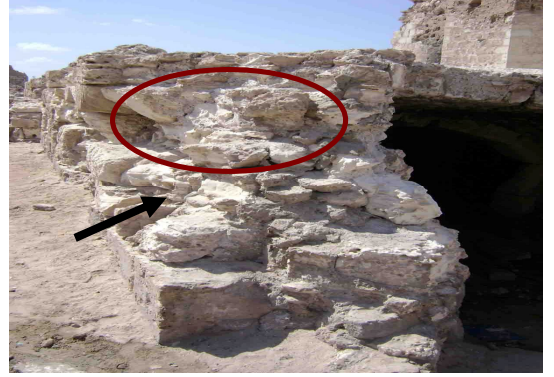
(لوحة رقم ٩) تآكل جدران الحوض الجاف وفقدان كتل حجرية منها
