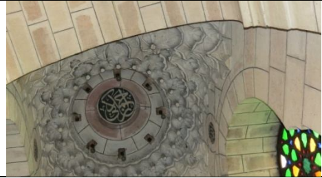
صورة رقم ٣٤: القبة والنافذة الجنوبية الشرقية للضريح.
