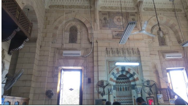
صورة رقم ٢٣: الجهة الجنوبية الشرقية وهي طبقة من مستويين ويوتر أعلى الجدران بحور كتابية وكورنيش مقرنص
