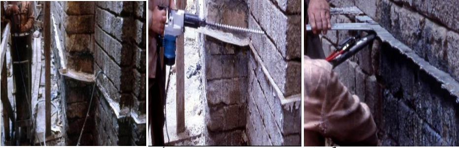
صورة (١٨) توضح عملية التثقيب صورة (١٩) توضح إدخال ألواح العزل صورة (٢٠) توضح عملية الحقن
