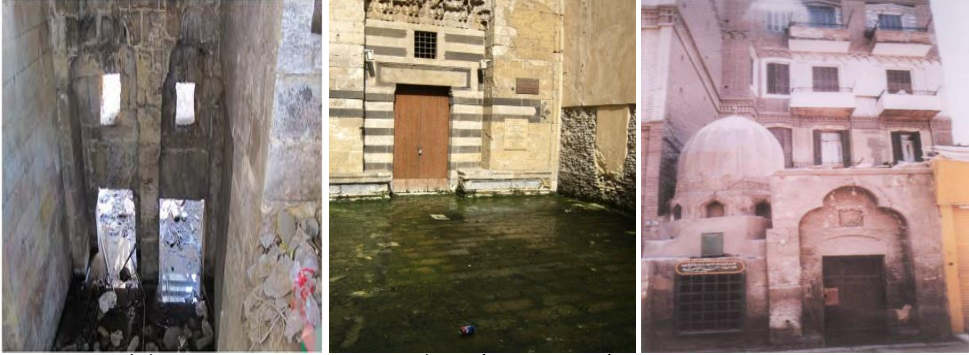
صورة (١٠، ١١، ١٢) توضح تأثير المياه الأرضية والصرف الصحي على قبة أحمد القاصد ومنشأة شرف الدين وأخيه وقبة صفي الدين جوهر (الباحث)
