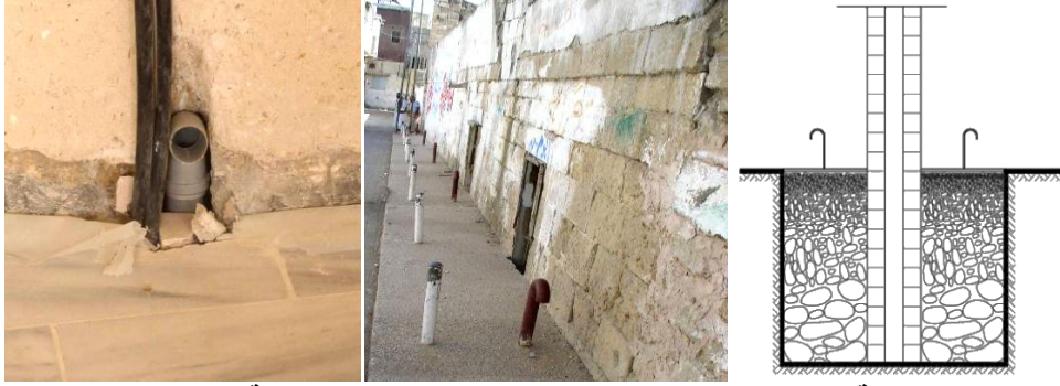
شكل (٣) معالجة صعود الماء بالجدار- صورة (١٤،١٣) توضح تهوية الخندق المحيط بالسور الخارجي من الأرض بالخاصة الشعرية و الداخلي للجامع العمري الكبير بغزة عن: أيمن عبد الهادي أبو شعبان، ٢٠٠٧م.
