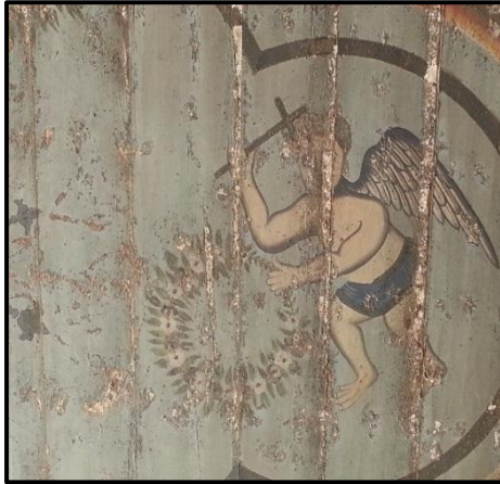
شكل (٣) مظاهر التلف بسقف قصر حنا بك
