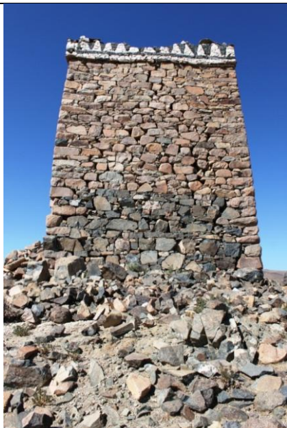
لوحة (٢٢) أطام (حصن) الغراب الشمالي: الواجهة الشمالية.
