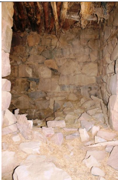
لوحة (٢٥) أطم (حصن) الغراب الجنوبي: الاستطراق الذي يلي مدخل الطابق الأرضي.
