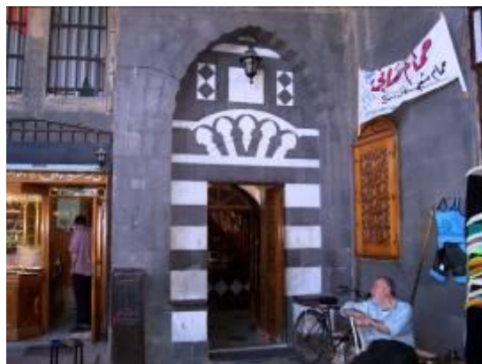
لوحة (١): مدخل الحمام بالطرف الشمالي من الواجهة الغربية تصوير الباحث
